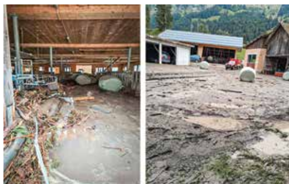
Quelle: Flutwelle verwüstet in Schangnau Restaurant, Hotel und Bauernhof – bauernzeitung.ch | BauernZeitung
